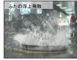
浮上・飛散するマンホールふた
