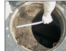
ボルト無緊結の古いタイプのマンホールふたの横ズレ
