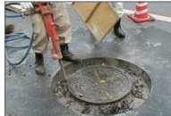
マンホールふたの改築
