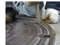
マンホールふた及び公共汚水樹ふたの点検・調査
