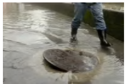
マンホールふた外れ
