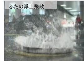
ふたの浮上飛散 浮上・飛散するマンホールふた
