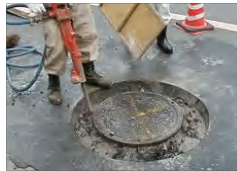
マンホールふたの改築
